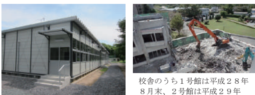
仮設校舎完成（平成28年7月7日）
